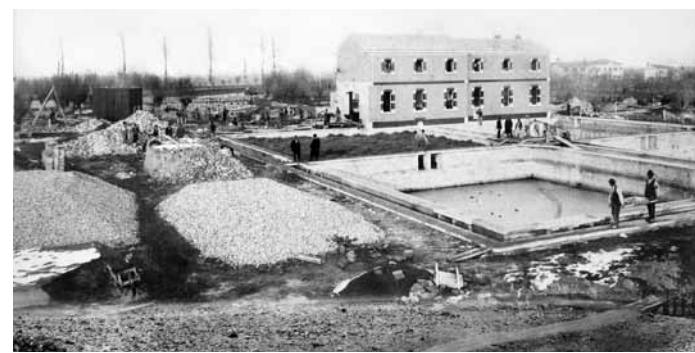
I lavori di costruzione delle vasche a sud dell'idroforo, 1880 ca.
